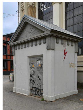
Fig. 19. Small transformer substation, typical design, at the corner of Brīvības iela and Unijas iela. 1922–1929
