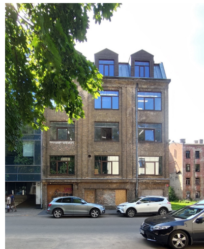
Fig. 10. Textile factory “Brāļi Svetlanovi” at Katoļu iela 21
