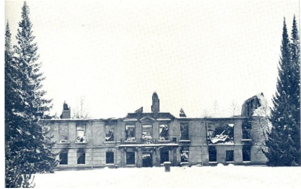
Fig. 7. Malpils Manor house after burning in 1905 [Livlands zerstörte Schlösser. T. 1. Rigaer und Wendenscher Kreis. Riga: Ernst Plates, 1905–1906, S. 12, 13.]
